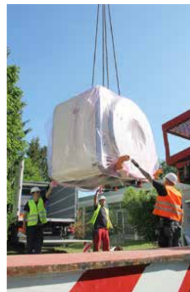
7 Tonnen wiegt der MRT, der deswegen per Kran angeliefert wurde.
